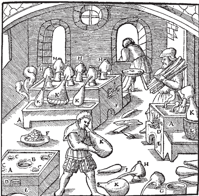
Abb. 23: Innenraum einer Destillationshütte im 16. Jahrhundert. So ähnlich dürfte es in der Bodenmaiser Vitriolölhütte auch ausgesehen haben. Mit „H“ sind die Destillationshelme bezeichnet.
