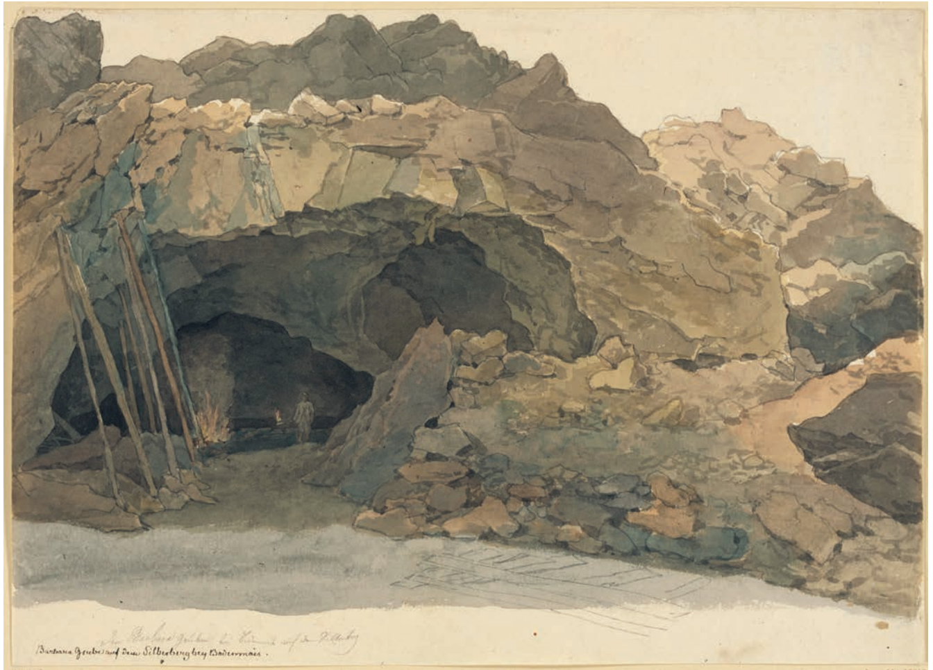
Abb. 10: Geräumiger Abbau im Eingangsbereich der „Barbaragrube auf dem Silberberg bei Bodenmais“ im Jahre 1805. Diese weiten Baue gehen auf hohe Erzmächtigkeiten und die Gewinnung durch Feuersetzen zurück. Der dargestellte Bereich gehört heute zum Besucherbergwerk am Silberberg.
